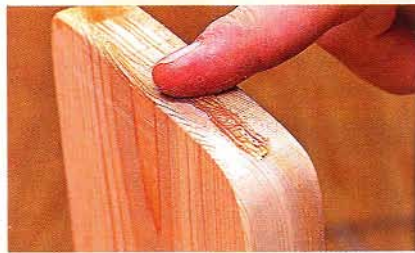
Втирайте эффективный прозрачный клей-герметик в торцы досок. Здесь мы используем эластичный полимер.
