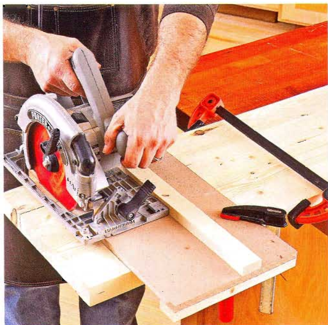
Выровняйте пильный край приспособления с линией разметки плечиков, закрепите основание струбинами и сделайте пропил, формирующий плечики в соединениях.
